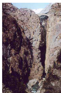
Le pont du Châtelet sur la Haute Ubaye (Alpes de Haute-Provence) enjambe un canyon sous-glaciaire et postglaciaire (photo prise de l'aval).
